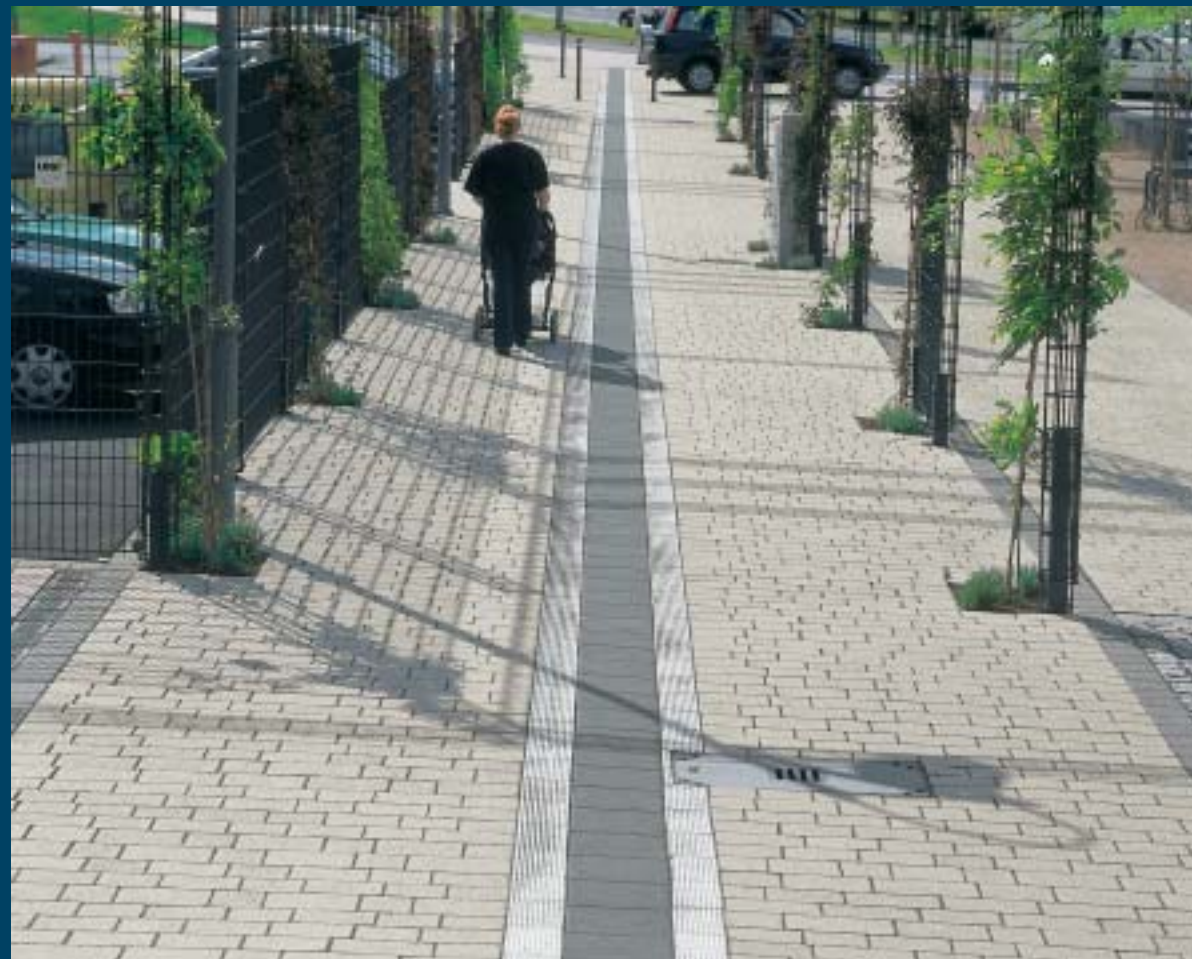
La Strada Pflaster rinnit Weißgranit, Blindenleitplatten Weiß, Kontraststreifen aus Platten 40 x 40 cm rinnit Basalt
