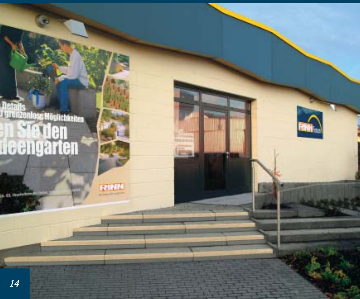
◁ Bi-color Blockstufen rinnit Granit mit Kontraststreifen rinnit Quarz
