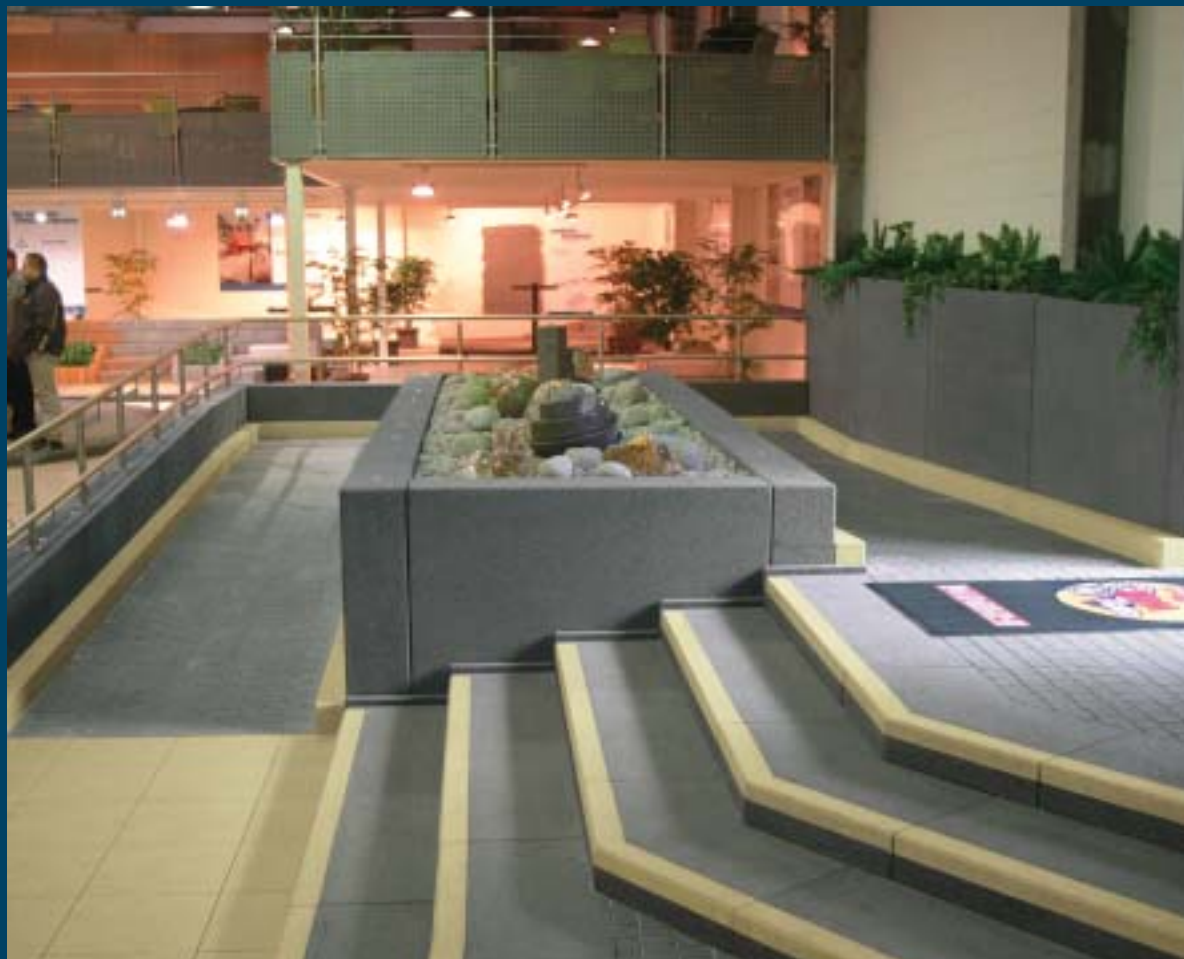
▷ Bi-color Blockstufen rinnenit Basalt mit Kontraststreifen rinnenit Quarz, Rampenanlage rinnenit Basalt mit Radabweiser rinnenit Quarz
