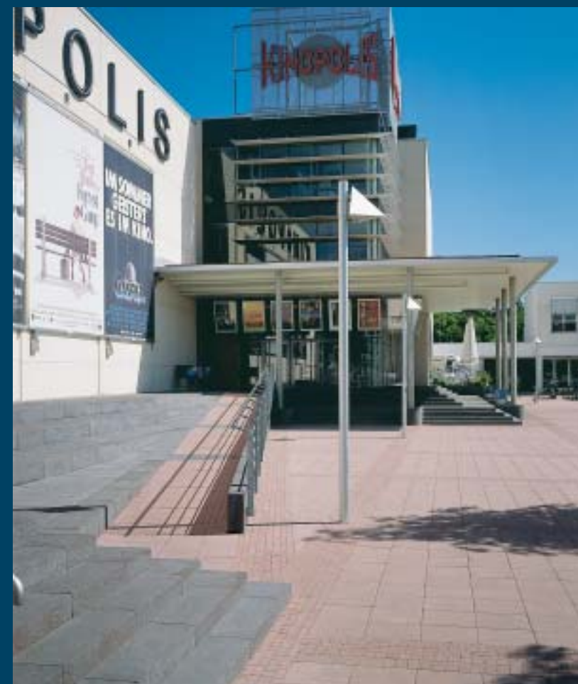
◁ Blockstufen und Mauerwinkel rinnit Basalt, Platten 40 x 40 cm und Nostalgo Pflaster rinnit Porphy
