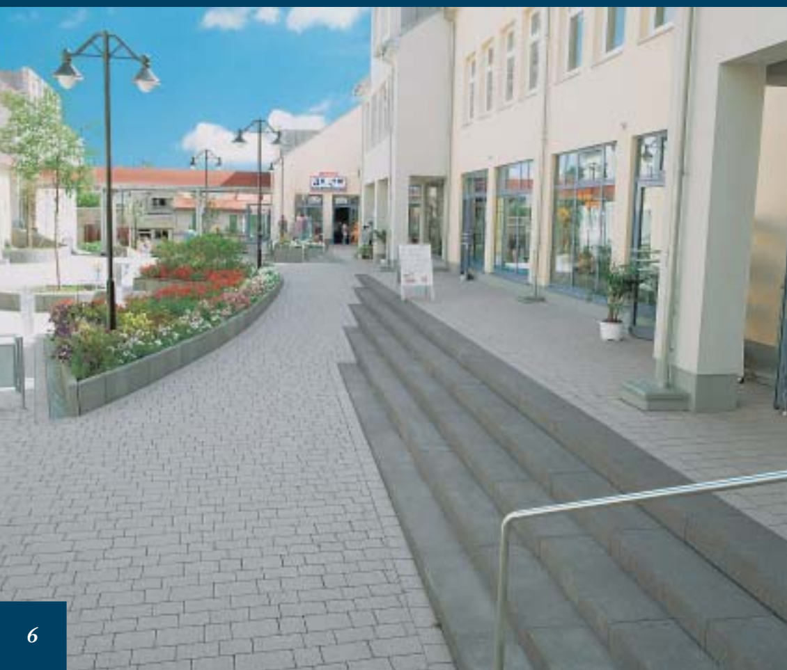
◀ Blockstufen rinnt Basalt, La Strada Pflaster rinnt Granit, Mauerwinkel rinnt Basalt
